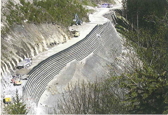
Bild 1. Bis zu 28 m hohe KBE Konstruktion verhindern das Abrutschen des Hanges
