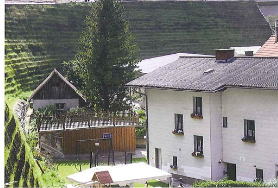
Bild 2. Die serpentinartige Trasse nach der ersten Vegetationsperiode (Fotos: HUESKER Synthetic)
