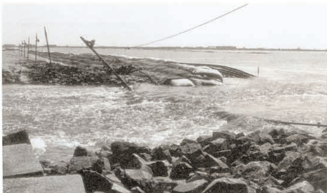
Bild 1. Rüstersieler Watt: 5000 großformatige Huesker-Nyloncontainer waren im Juli 1963 notwendig, um den Deichschluß zu errichten
