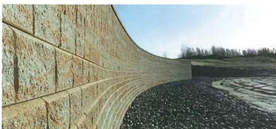
Bild 2. Die neue Hafenmauer nimmt einen bogenförmigen Verlauf.
