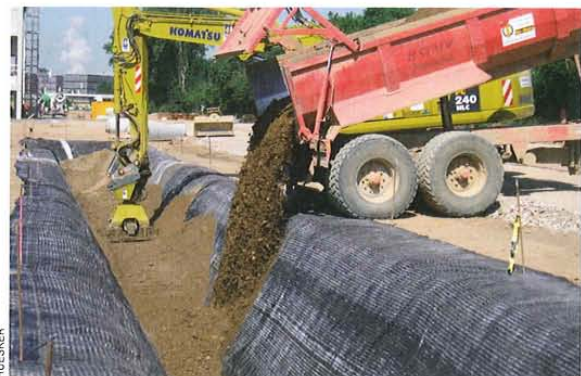
Einbau und Verdichtung der Sickerpackung in der mit NaBento abgedichteten Mulde.
