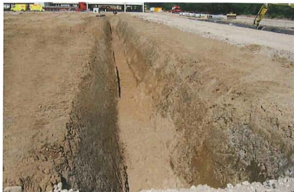
Die vorprofilierte Sickermulde vor Verlegung der Bentonitmatte.
