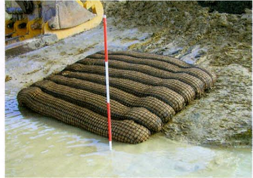
Erosionsschutzmatte aus HaTe – Gewebe mit Mineralgemisch
