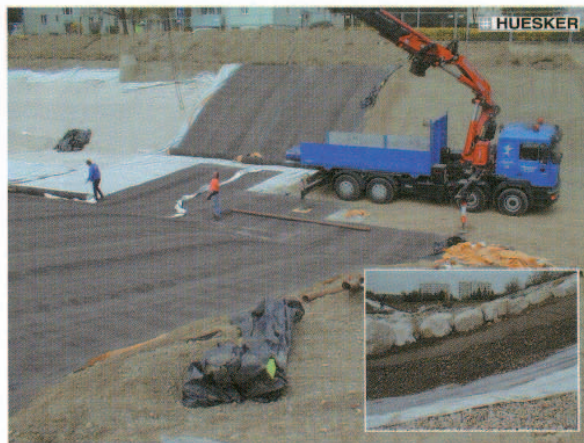
Das neue Flussbett der Glan wird mit der GTD NaBento von HUESKER ausgelegt.
