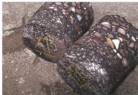
Bild 2. Bohrkern mit Gittern
