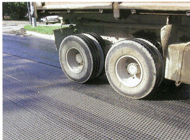
Bild 4. Befahren von HaTelit C 40/17 mit Mischgut LKW
