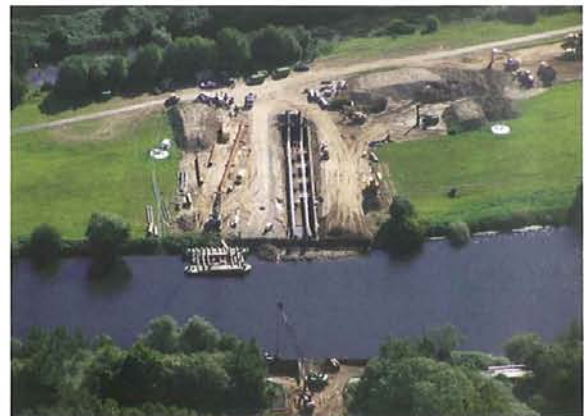
Trinkwasser-Doppeldüker DN 1400 in der Ruhr Foto: Klaus Stewering GmbH & Co. KG, Borken
