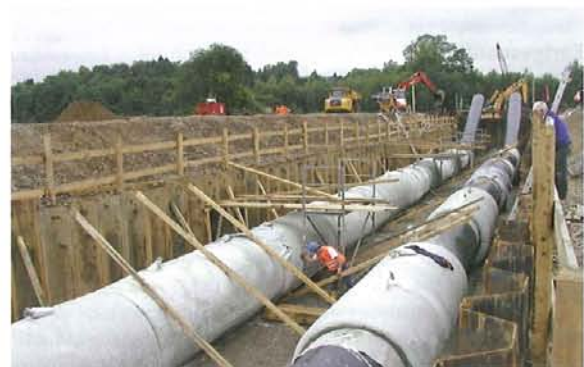
Incomat – Ummantelung der Rohre im Trockendock
