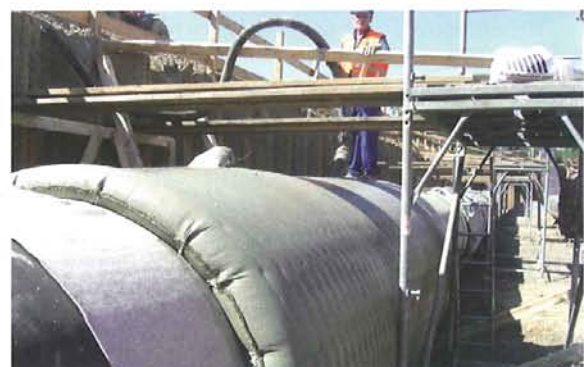
Befüllung eines Incomat – Elements mit Beton Fotos: HUESKER Synthetic GmbH
