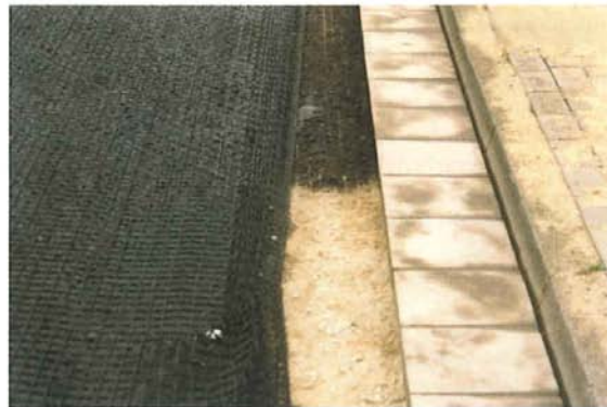
Bild 5. verlegte Bewehrung
