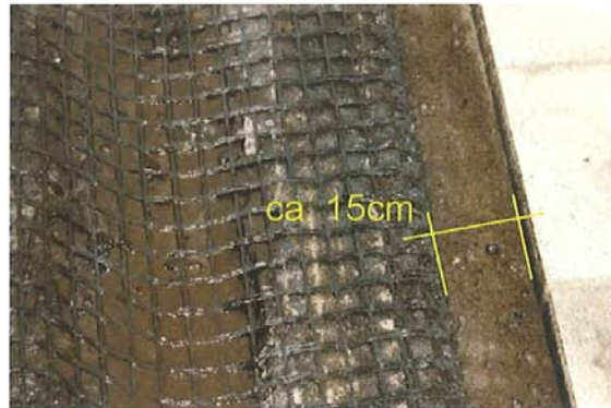
Bild 4. verlegte Bewehrung (Detail)
