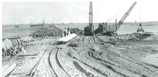
Auf Feldbahnen brachte man 1963 die insgesamt 25.000 Nylonsäcke zu ihrem Bestimmungsort. Später sollten sie den Deich am Rüstersieler Watt zu einem Bollwerk gegen die anstürmende See machen
