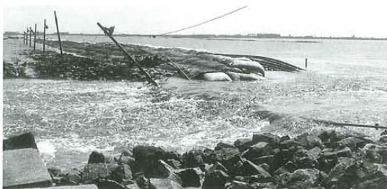
5.000 großformatige Nyloncontainer waren im Juli 1963 notwendig, um den Deichschluss zu errichten. Er bestand aus einem zweifachen Nylonsackdamm, im Kern mit Sand gefüllt.
