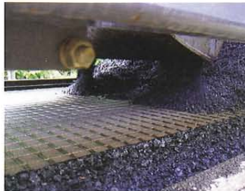
Bild 2: Einbau der Asphaltdeckschicht auf die Asphaltbewehrung
