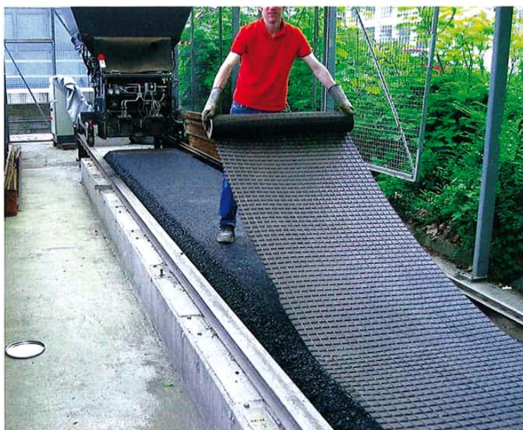
Bild 1: Verlegen der Asphaltbewehrung
