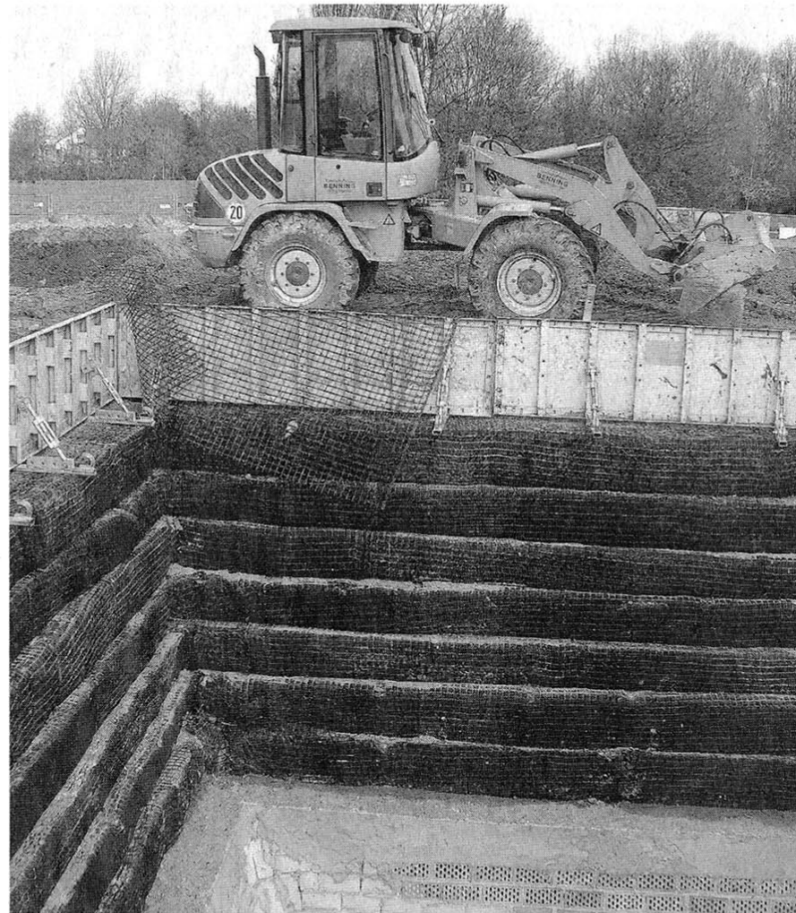
Direkt neben dem Aasee in Münster ragt zur Skulpturenausstellung ein gut vier Meter hoher Kirchturm aus dem Boden. Lagenweise wurde dazu die Böschung mit dem Geogitter Fortrac aufgebaut. Die Firma Huesker in Gescher ist Hersteller von Geokunststoffen.
