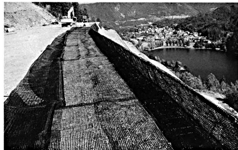
Die flexiblen, hochfesten Fortrac-Bewehrungsgitter werden horizontal positioniert, anschließend wird Schüttboden aufgebracht und verdichtet.
