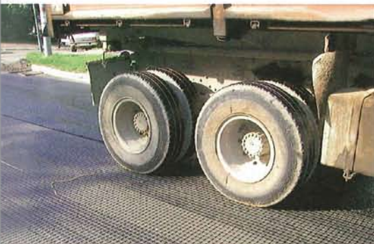
Befahren von Hatelit mit LKW
