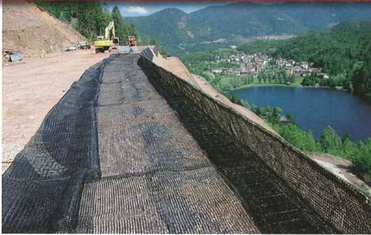
Die flexiblen, hochfesten Fortrac-Bewehrungsgitter werden horizontal positioniert.
