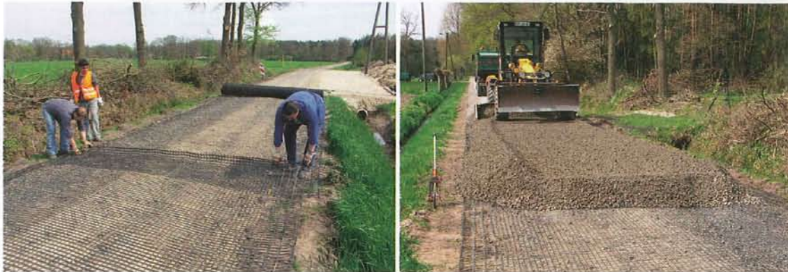
Dehnsteife Fornit-Geogitter verringern die Anforderungen an die Tragfähigkeit der darunter liegenden Böden erheblich, sichern den festen Verbund der Tragschicht und verhindern seitliche Verschiebungen.
