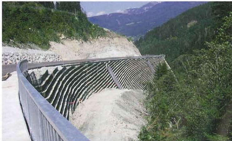
Brückenanschluss der Konstruktion bewehrter Erde (KBE)
