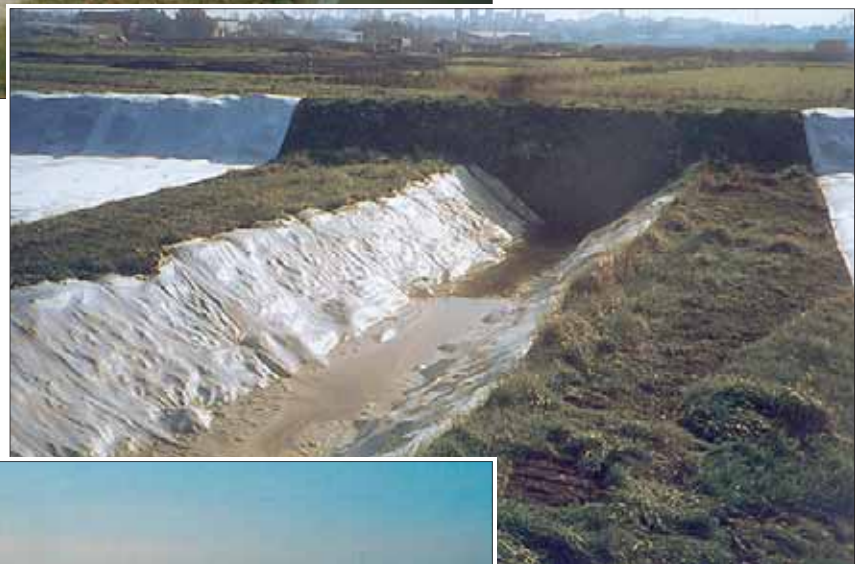
Zusätzliche Bewehrung im vorhandenen Graben
