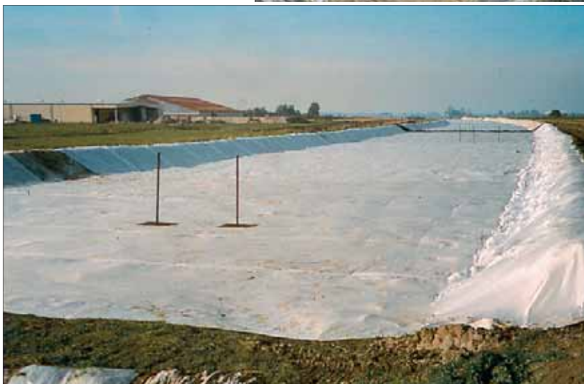
Bewehrung für den Damm der Ortsumfahrung mit Stablenka® 300/45
