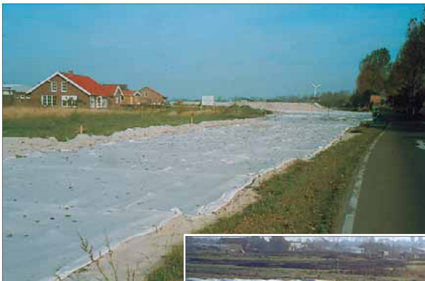
Bewehrung für die Zufahrt zur Ortsumfahrung Jever mit Stablenka® 150/45
