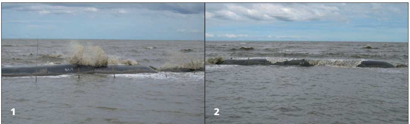
Abb. 1/2: SoilTain® Schläuche als Wellenbrecher im Tidewasserbereich (Ebbe)
