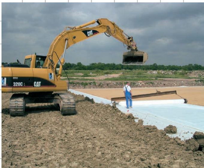
Abdeckung eines Schlammbeckens
