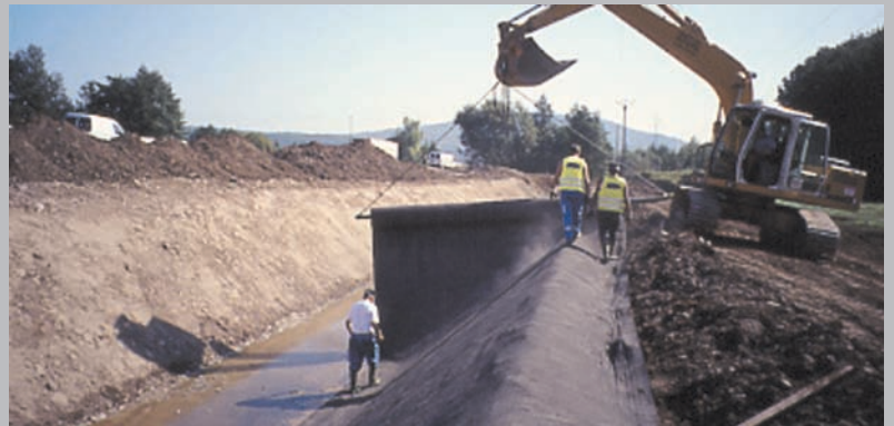
Flußbettabdichtung mit NaBento®
