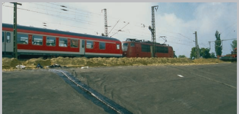
Abdichten von Bahnanlagen mit NaBento®
