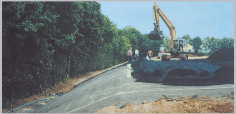
Oberflächenabdichtung von Deponien: mit NaBento®
