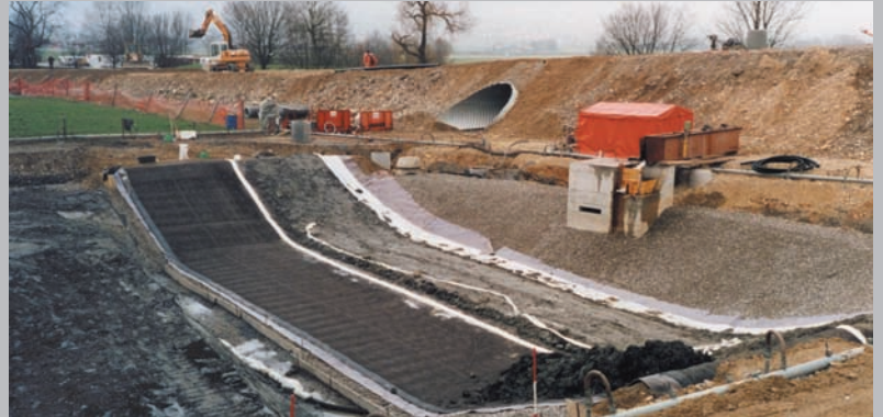
Regenrückhaltebecken - Abdichtung mit NaBento®
