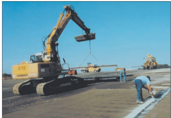
NaBento® - Einsatz im Deponiebau
