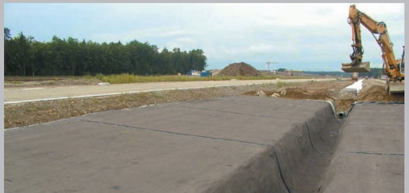
Grundwasserschutz mit NaBento® im Verkehrswegebau
