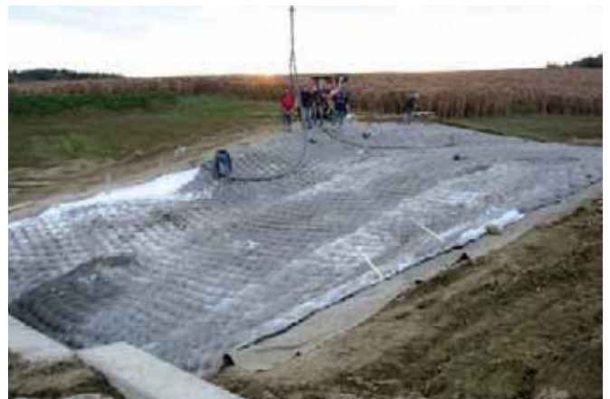
Incomat® FP nach der Befüllung mit Beton
