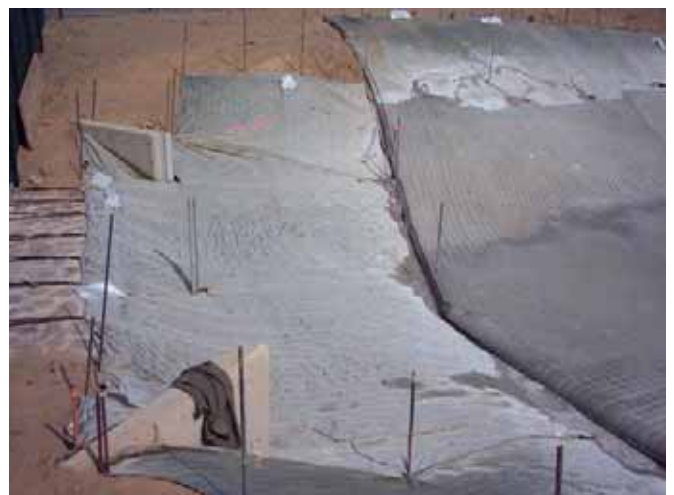
Einbau bei geometrisch schwierigen Randbedingungen (2)
