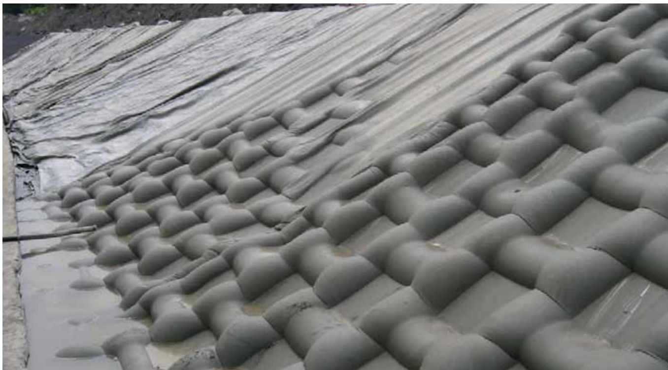
Einbau von Incomat® Crib
