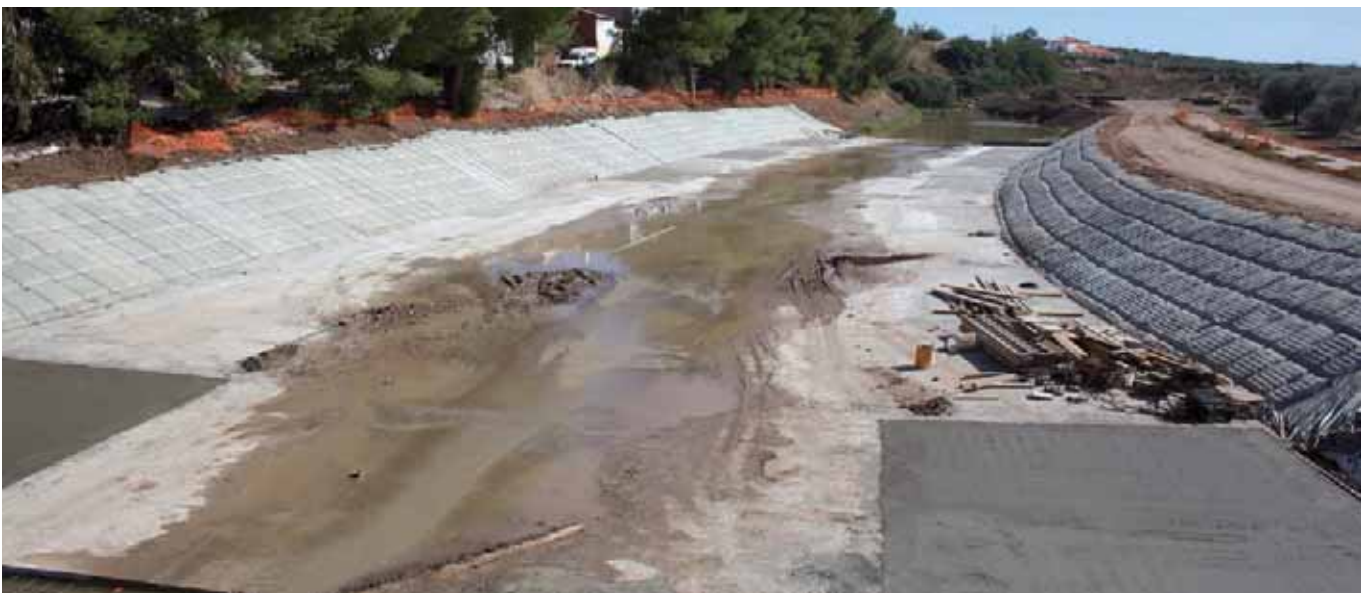
Böschungssicherung mit Incomat® Flex
