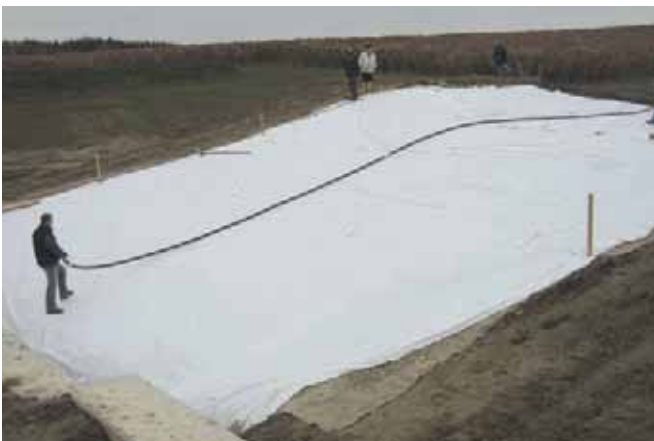
Incomat® FP wird für den Einbau vorbereitet
