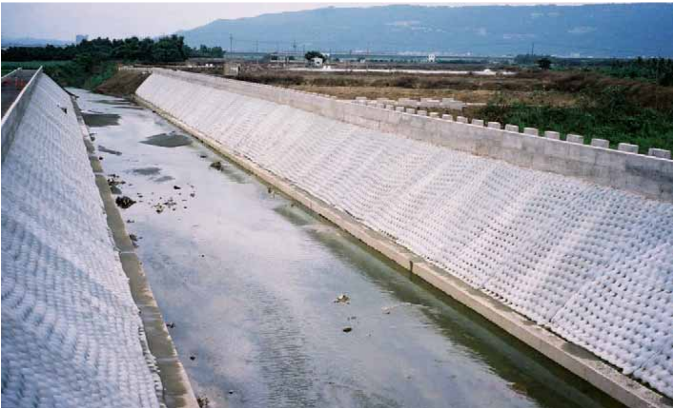
Mit Incomat® FP ausgekleideter Entwässerungskanal
