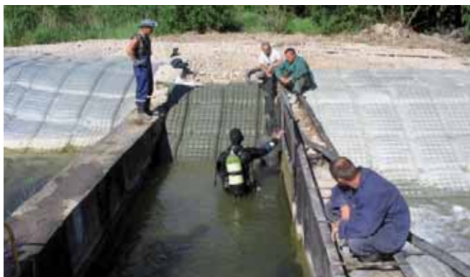
Einbau von Incomat® Flex unter Wasser
