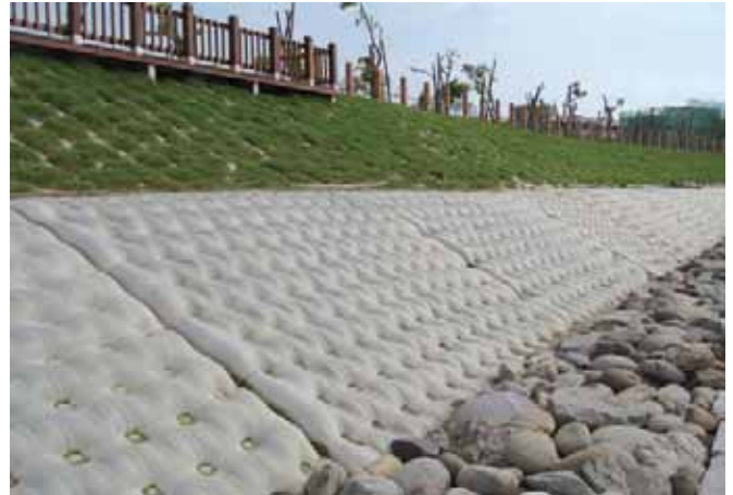
Nach der Fertigstellung (im unteren Bereich der Böschung Incomat® FP , im oberen Bereich der Böschung Incomat® Crib ) (2)
