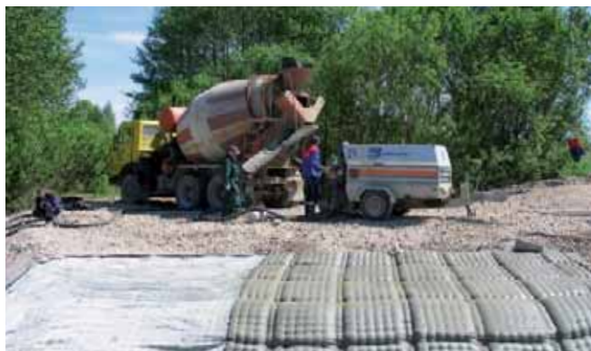
Einbau von Incomat® Flex
