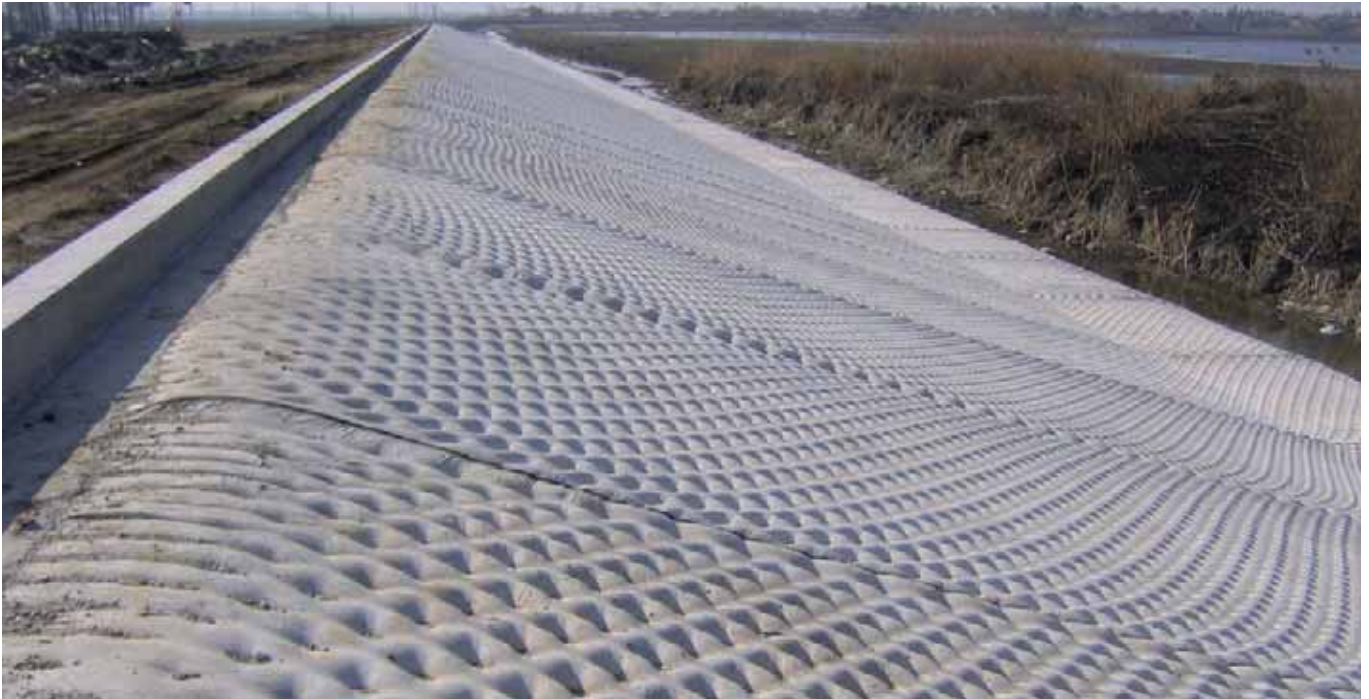
Böschungssicherung mit Incomat® FP
