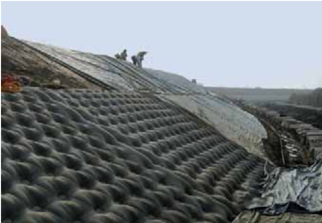
Einbau von Incomat® FP (1)
