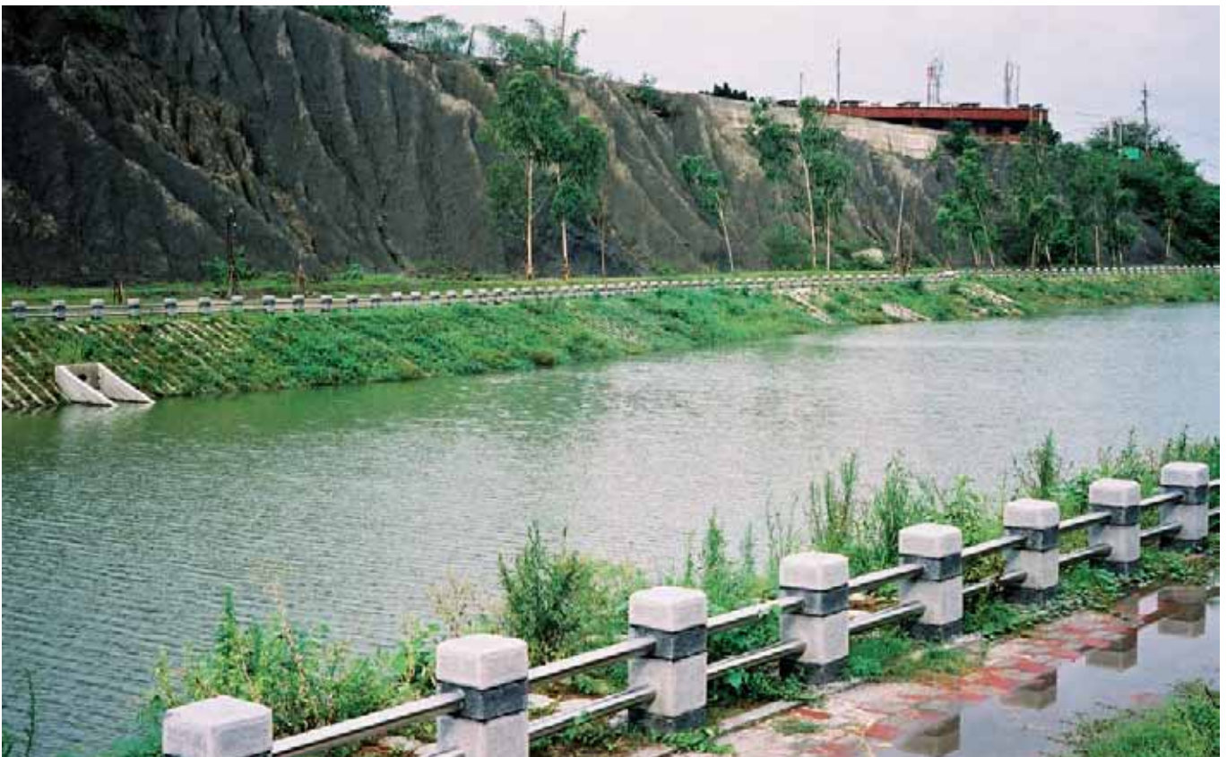
Begrünung nach Fertigstellung der Baumaßnahme (3)
