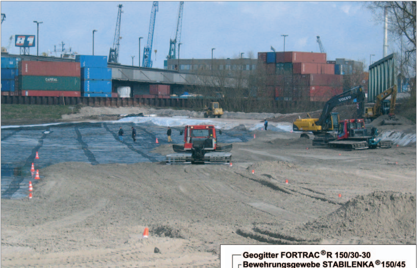
Übersicht: Becken des Rodewischhafens während der Aufbringung der ersten Sandlage
