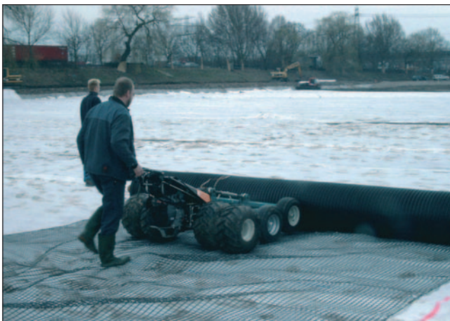
Einbau des Geogitters Fortrac®
