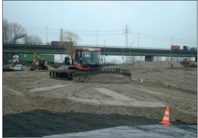
Überschüttung der Geokunststoffe mit Sand
