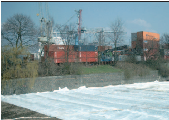
Einbau des Stablenka® – Gewebes
