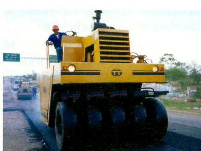
Figura 9 – Procedimento de compactação convencional da capa asfáltica
