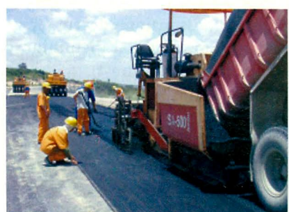
Figura 8 – Equipamentos sobre a geogrelha na execução da capa asfáltica
