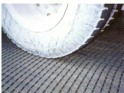
Figura 8 – Equipamentos sobre a geogrelha na execução da capa asfáltica
