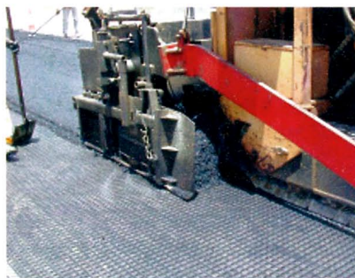
Figura 6 – Desenrolamento mecânico e manual da bobina de geogrelha e adequação sobre áreas de descontinuidades
