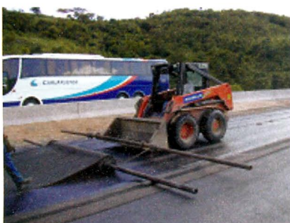
Figura 6 – Desenrolamento mecânico e manual da bobina de geogrelha e adequação sobre áreas de descontinuidades
