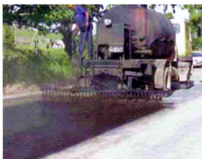
Figura 5 – Aplicação da pintura de ligação na superfície para receber a geogrelha
