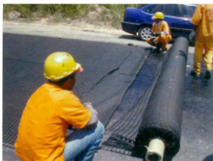
Figura 7 – Sobreposição de geogrelha
