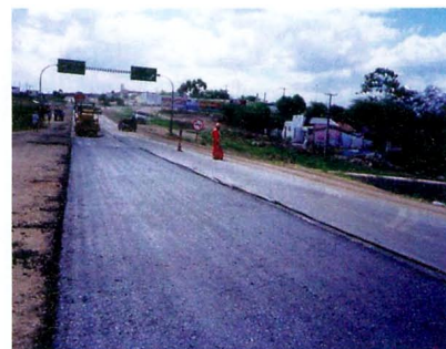
Figura 5 – Aplicação da pintura de ligação na superfície para receber a geogrelha
