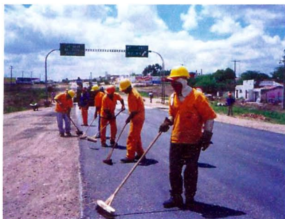
Figura 4 – Limpeza manual e mecânica
