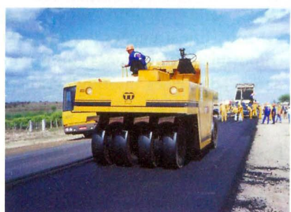
Figura 9 – Procedimento de compactação convencional da capa asfáltica
