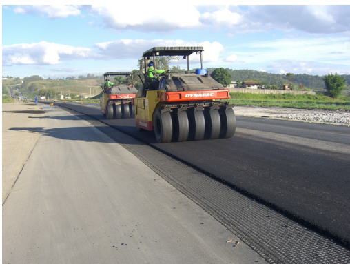
Figura 13 – Compactação da camada asfáltica.
