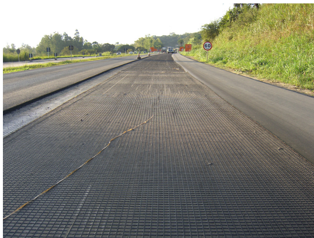
Figura 9 – Vista do Hatelit C 40/17 instalado.
