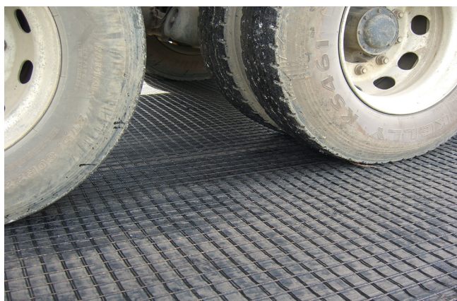
Figura 12 – Acabadora movimentando-se sobre o Hatelit C 40/17
