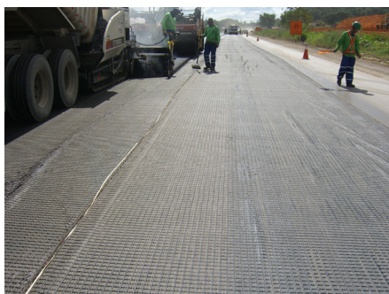
Figura 10 – Vista do Hatelit C 40/17 instalado e a execução da camada asfáltica (CBUQ).
