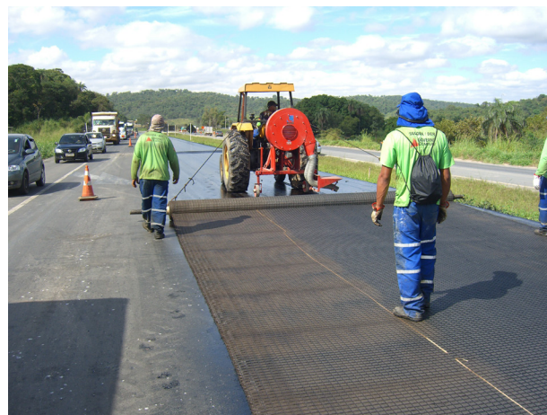
Figura 8 – Instalação do Hatelit C 40/17.
