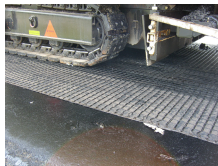
Figura 11 – Acabadora movimentando-se sobre o Hatelit C 40/17
