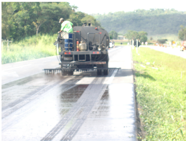
Figura 7 – Imprimação da superfície do pavimento
