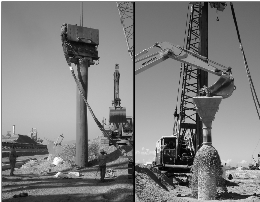
Figura 8. Ejecución de las columnas granulares encamisadas con geotextil
