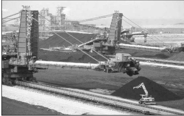
Figura 4. Patios de almacenamiento de carbón y coque: pilas de materiales y pistas con las maquinas de apilamiento y recuperación de 750 toneladas operando entre ellas
