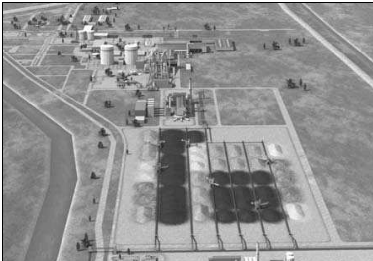
Figura 1. Esquema general de la planta de acero TKCSA: Pilas de disposición de materiales y pistas para las máquinas recuperadoras
