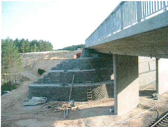
Bild 1 Brückenwiderlagerwände an der Via Baltica nahe Riga
