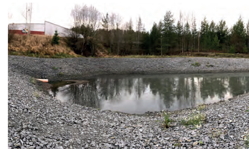
Grubenwasserbehandlung im Bergbau Finnland | Auch im Bergbau kann metallhaltiges Wasser in Becken behandelt werden. Für die Grubenwasserbehandlung in einer stillgelegten Nickelmine wurden zwei Filterbecken mit Tektoseal Active HM ausgekleidet.
