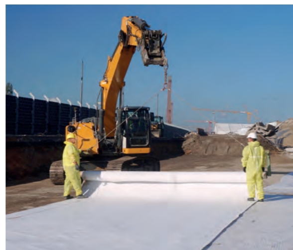
Schadstoff- und Geruchsfilter auf Altlast Deutschland | Abdeckung einer Altlast als Sicherheitsmaßnahme für Bauarbeiten. Einfache Verlegung von Tektoseal Active AC. Schadstoffe und Gerüche werden von der Aktivkohle gebunden und gelangen nicht an die Geländeoberfläche. Anwendung als temporäre oder permanente Altlastsicherung.
