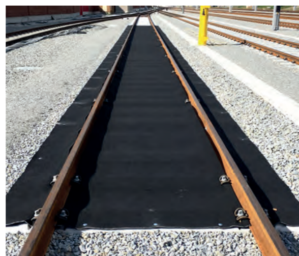
Ölabsorption im Abstellgleis Österreich | Im Abstellgleis eines Bahnhofes werden Züge gewartet, gereinigt und betankt. Um den Untergrund zu schützen, wurde Tektoseal Active AS verwendet. Die Rollen werden ab Werk auf die passende Breite zugeschnitten und sind somit einfach zu verlegen. Um die Beständigkeit gegen UV-Strahlung zu erhöhen, wurde das Produkt mit einem UV-stabilisierten Gewebe ausgestattet.
