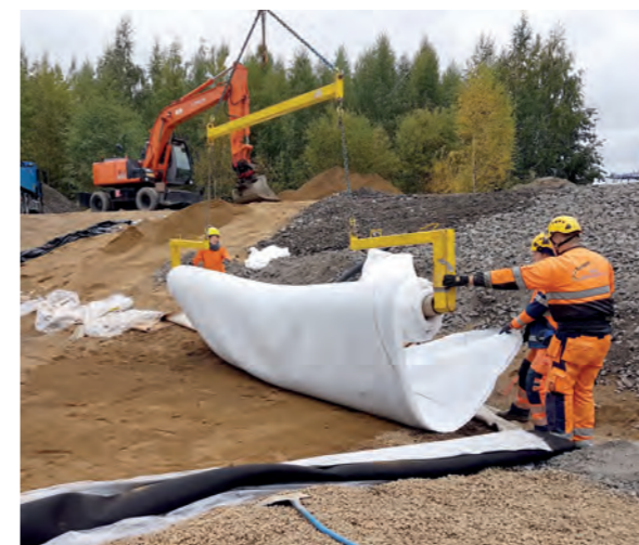
Niederschlagsbehandlung Finnland | Der mit PAK und MKW belastete Niederschlagsabfluss von versiegelten Flächen wird in einem Regenrückhaltebecken behandelt. Durch die Installation von Tektoseal Active AS und AC in der Beckensohle werden die Schadstoffe aus dem Wasser gefiltert, ehe es versickert. Die Beckenwandungen sind weitgehend wasserundurchlässig mit einer Tondichtungsbahn ausgekleidet.
