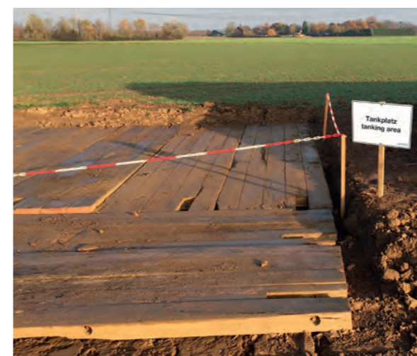
Temporäre Baustellentankstellen Deutschland | Für eine Baumaßnahme „auf der grünen Wiese“ wurde eine temporäre Betankungsfläche für Baumaschinen geschaffen. Durch den Einsatz von Tektoseal Active AS ist der Untergrund vor auslaufenden Treibstoffen gesichert. Die Holzbohlen oberhalb der Filtermatte gewährleisten die Befahrbarkeit und den Schutz der Matte z. B. gegen UV-Strahlung und mechanische Einwirkungen.
