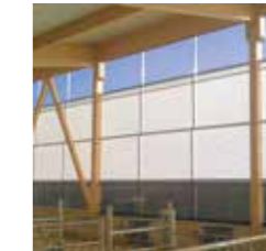
Lubratec Wickellüftung Kälber
