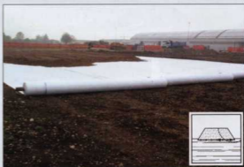
Progetto: Lonigo (VI) - Problematica: rinforzo alla base di un rilevato stradale - Materiale: geotessile Stabilenka® 400 kN/m
