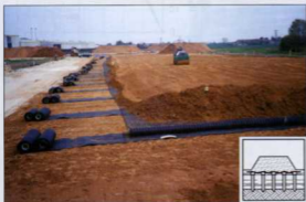
Progetto: Selby (UK) - Problematica: rinforzo sulla testa di pali Materiale: geogriglia Fortrac® 400 e 1600 kN/m
