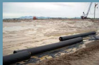
Aplicação do geotêxtil tecido Hate para estabilização da plataforma de trabalho
